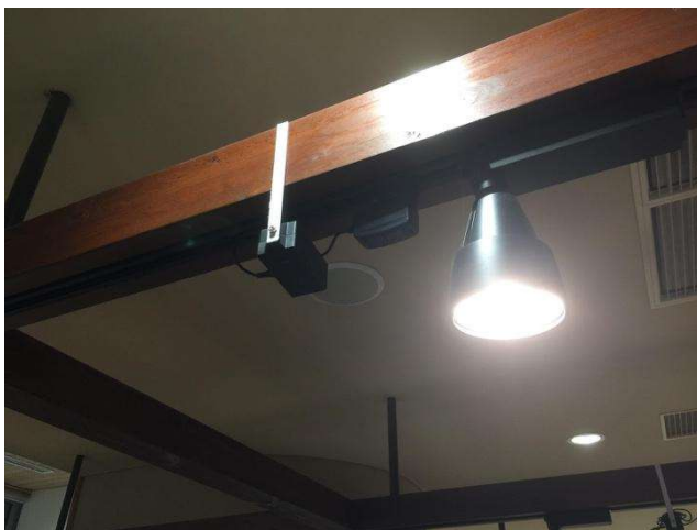
図 4. 実際の設置状況
