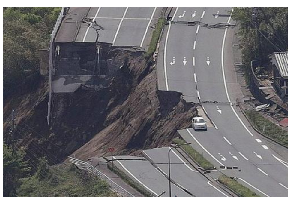
地震後の陥没地形
