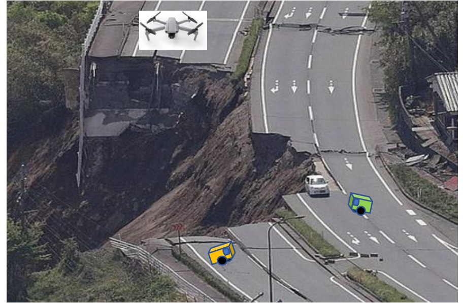
地震や洪水等による被災地の現場
