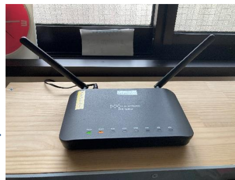
ルーターの設置
