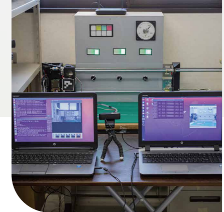
大塩浄化センター内の様子
