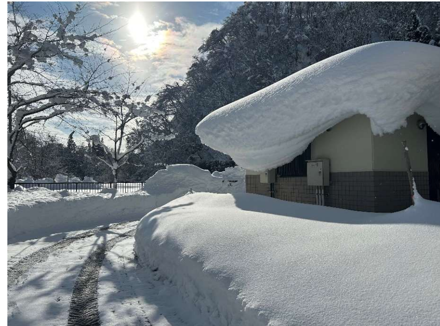
図13 大塩浄化センターの様子②
