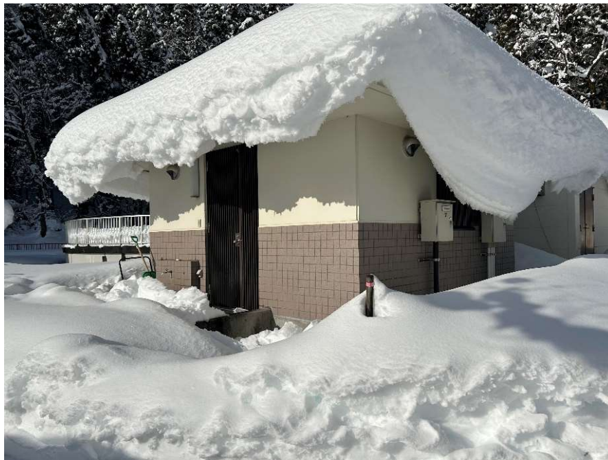
図12 大塩浄化センターの様子①
