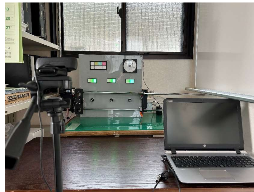
図17 大塩浄化センター内
