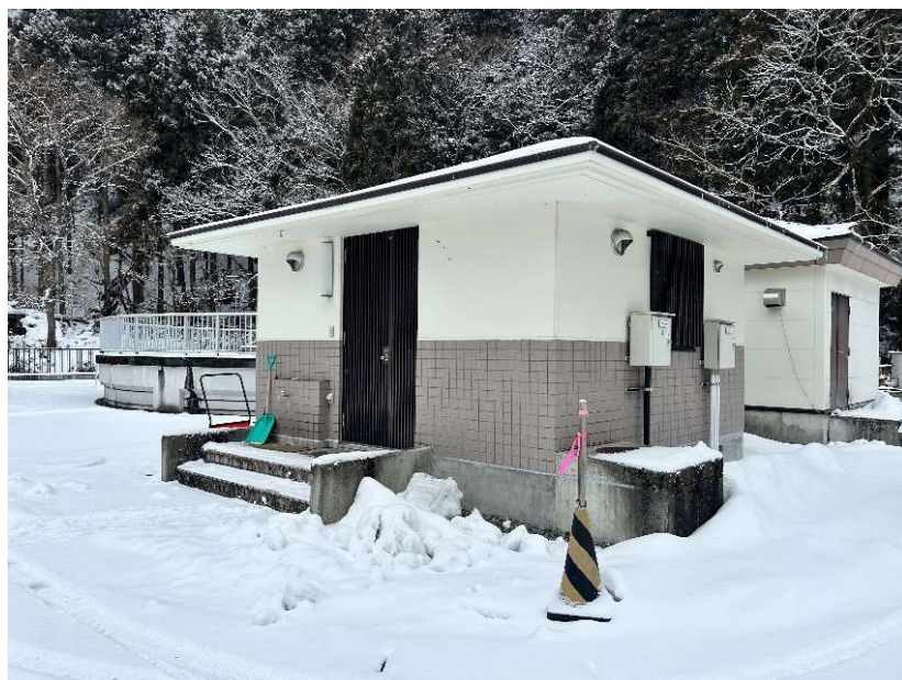
図16 北塩原村施設 大塩浄化センター
