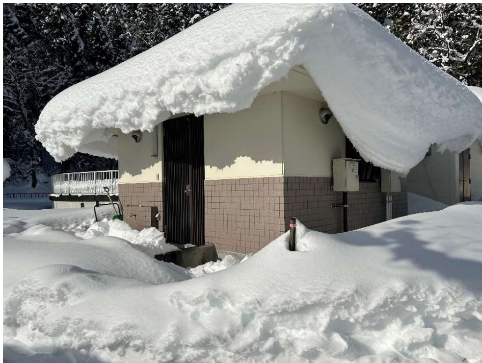
図3 山間部の豪雪地帯における 下水道施設
